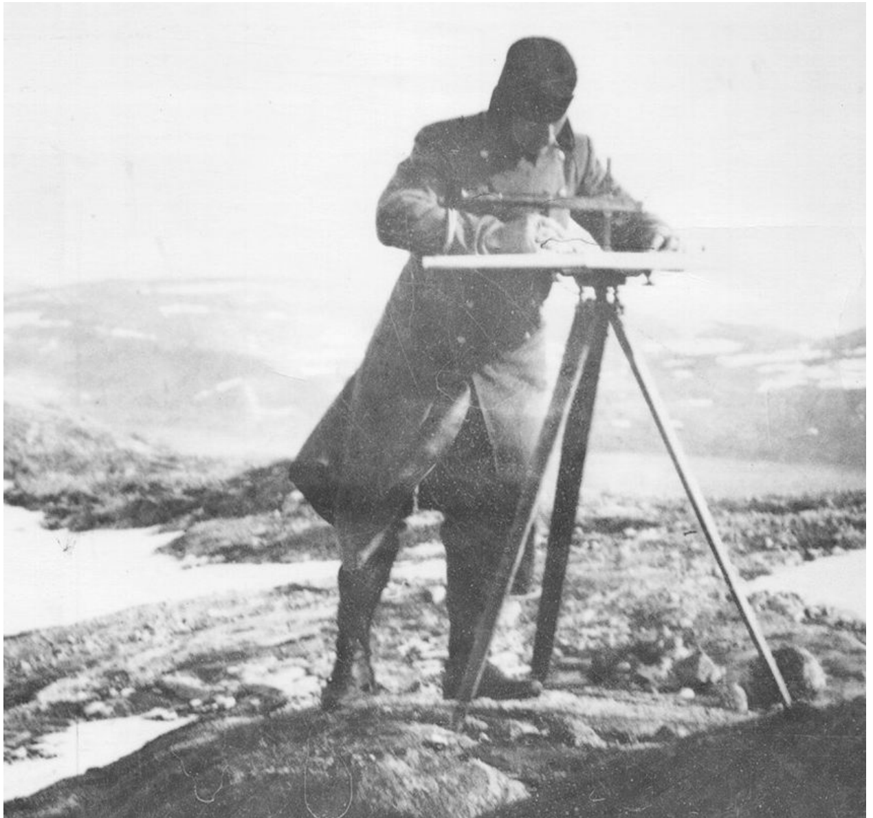
De økonomiske kartene fra 1805 til 1818 ble fremstilt ved hjelp av målebordsmetoden. Bildet viser målebordskartograf på Langfjellet i Nordland 1907.
