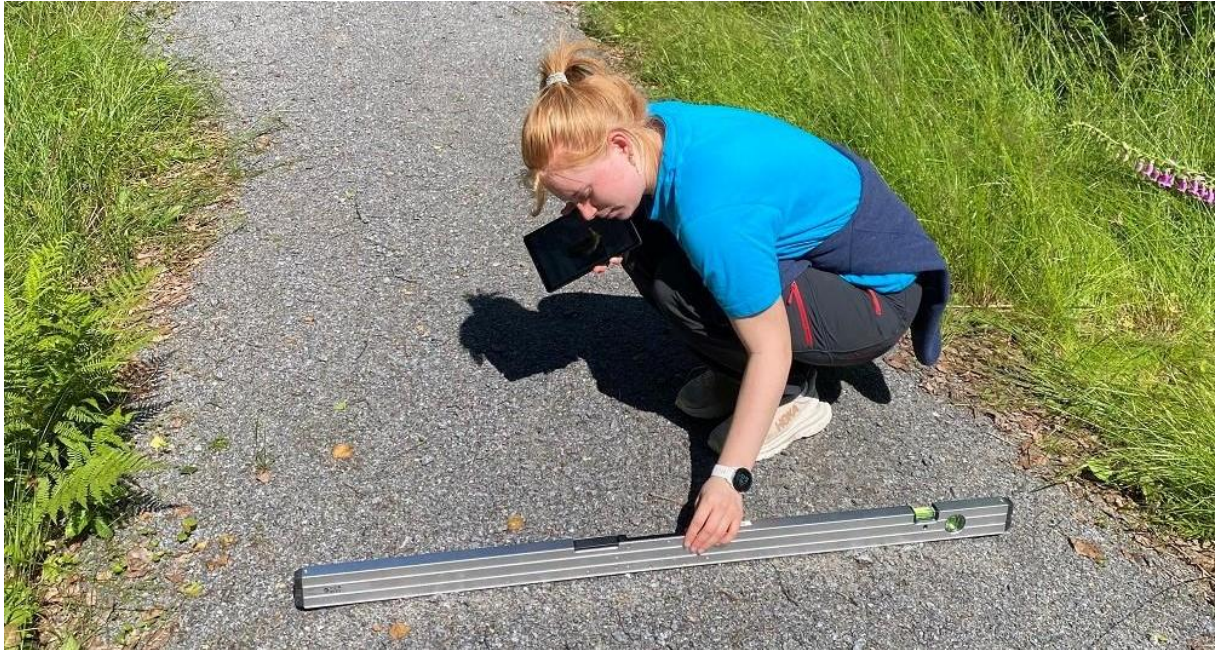
Figur 27: VATER: Måling av tverrfall med et digitalt vater. Foto: Inger-Marie Juel Gulliksen, Oslofjordens Friluftsråd.
