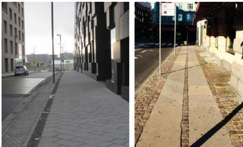
Figur 6: LEDELINJE: En linje med brostein gir både visuell og taktil kontrast, og kan være en god ledelinje. Foto: Fra registrerte tilgjengelighetsdata.
